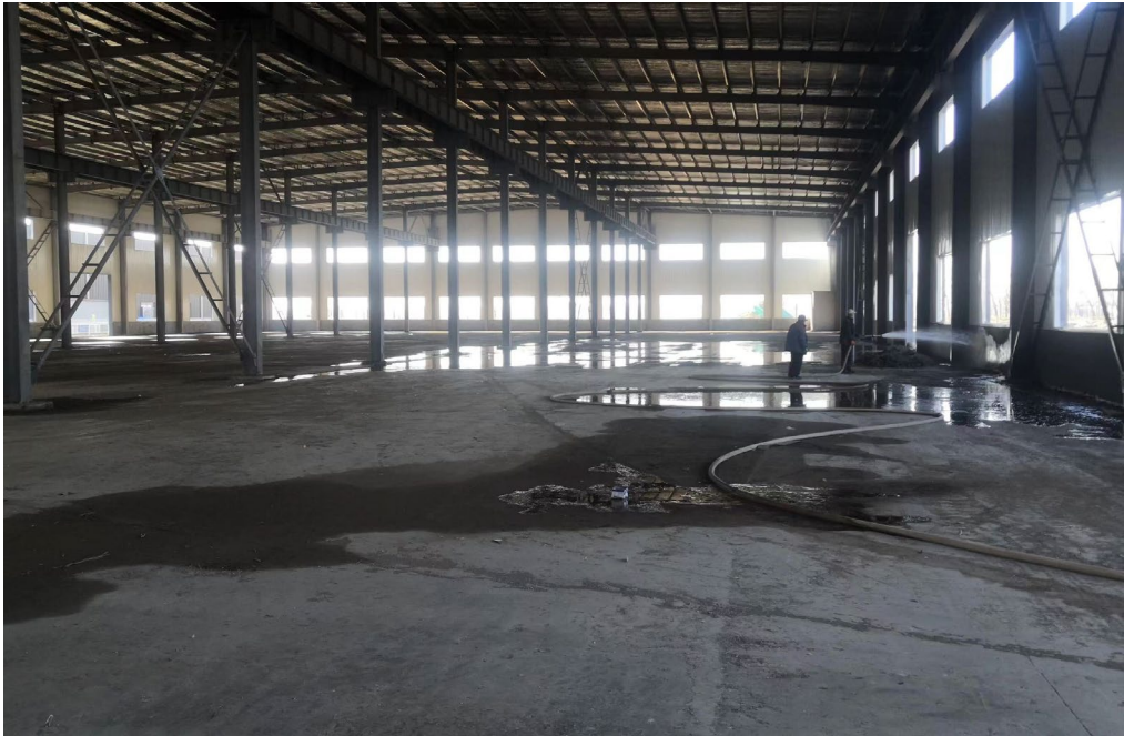
图 2-4 厂房内部空间照片
